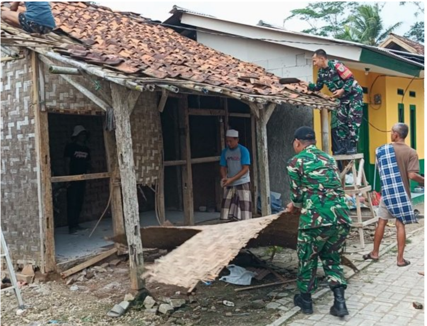
Pembongkaran Rumah Bapak Narmin
